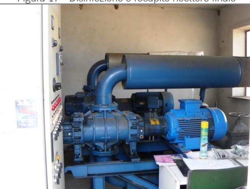
Figura 19 - Compressori di processo
