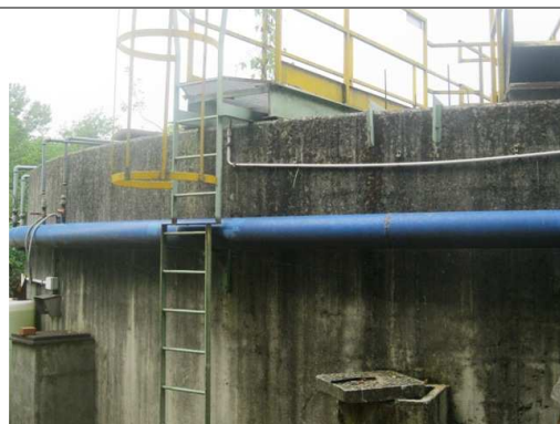
Figura 6 - Scala a pioli di accesso passerella centrale
