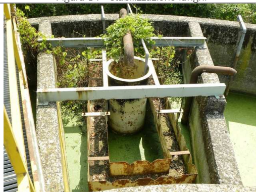
Figura 16 - Ispessimento fanghi
