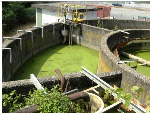
Figura 14 - Stabilizzazione fanghi
