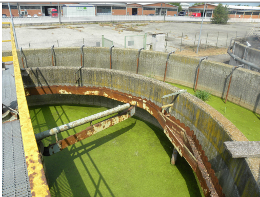
Figura 13 - Sfioro sedimentatore e scum-box
