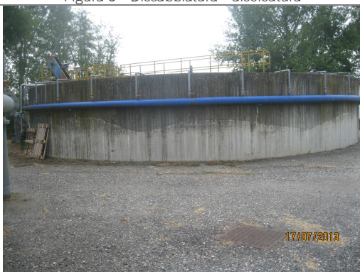
Figura 11 - Tubazione aria di processo
