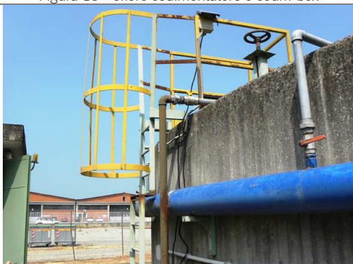
Figura 15 - Scala a pioli accesso stabilizzazione
