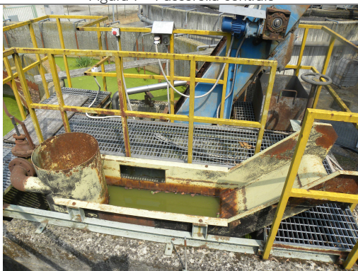
Figura 9 - Dissabbiatura - disoleatura
