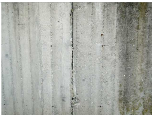
Figura 5 - Giunti vasca seconda linea
